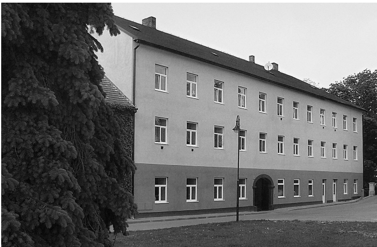
„Stará fabrika“, původně přádelna vlny vybudovaná Mosesem Löw-Beerem, dnes bytový dům na ulici Hybešova čp. 40 ve Svitávce, foto Pavel Krejcar 2011
