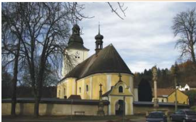
Dokončená oprava hřbitovní zdi Vendolí
